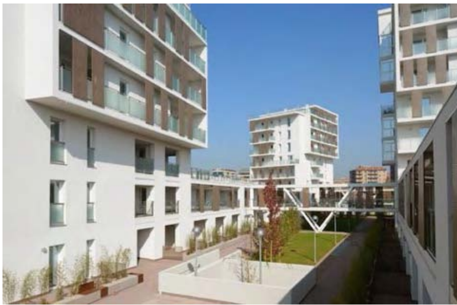
Figura 21. Vista del complesso residenziale “Cenni” di Milano
